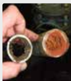
Sistema de tuberías
